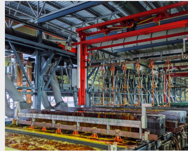
58 Công nghiệp mạ
